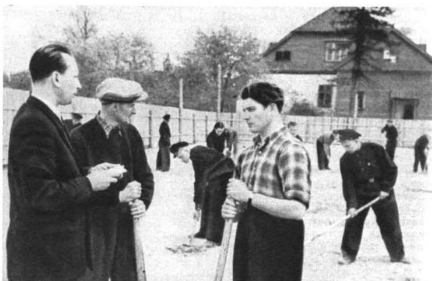
Посмотреть на строительство двух теннисных площадок в Пайде приехал председатель президиума республиканской теннисной секции Юрий Ребане (первый слева).
