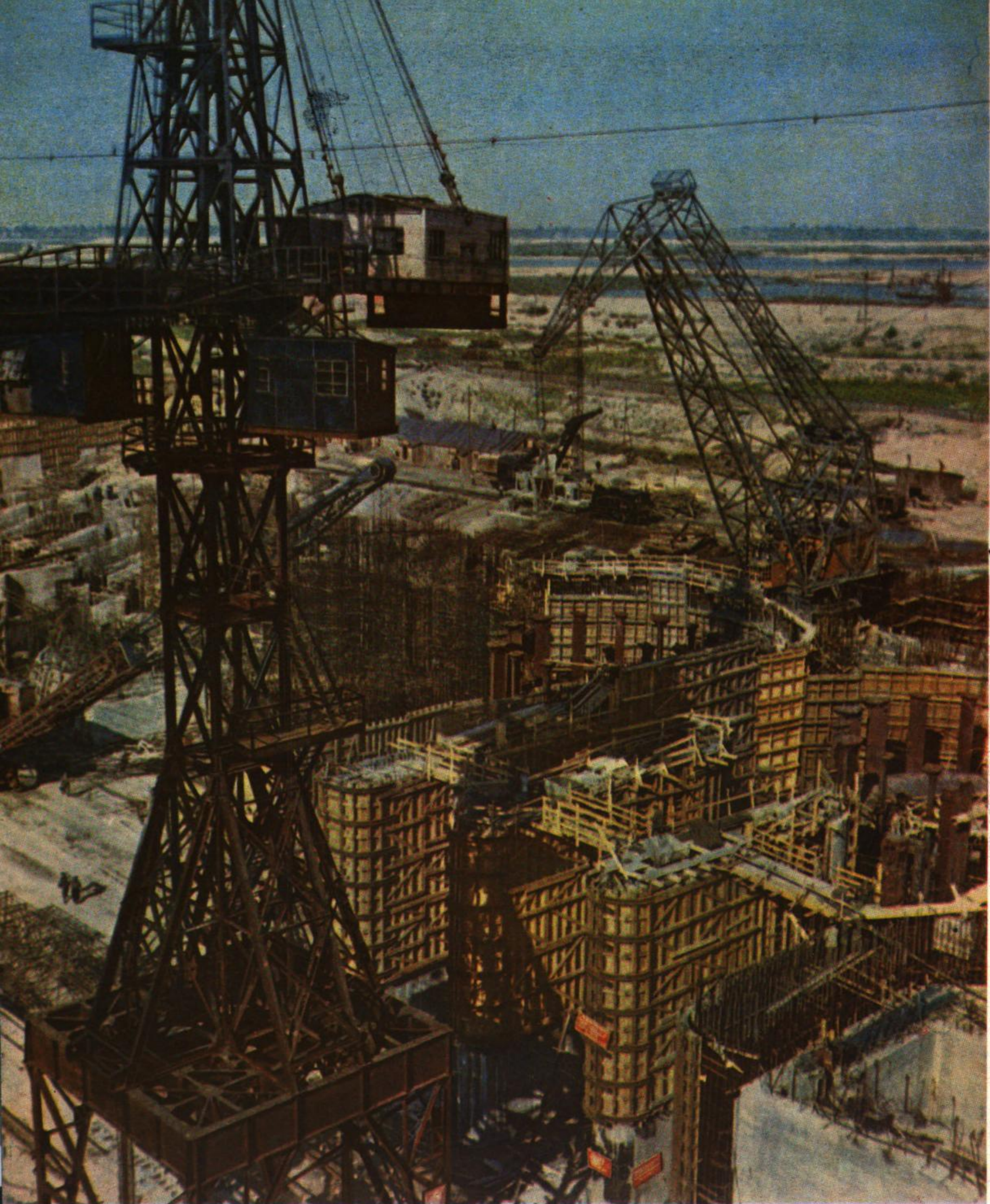
На строительстве Горьковской гидроэлектростанции.
