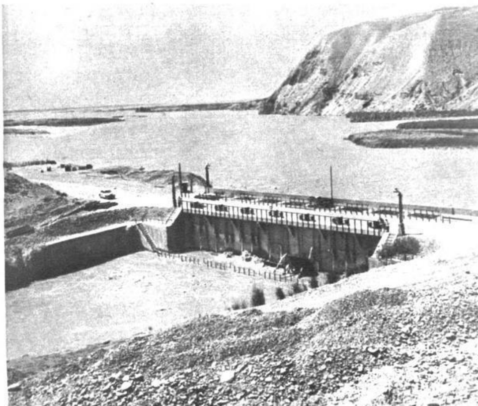
Главное сооружение Вахшского оросительного канала.
